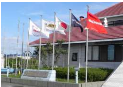
大阪北港マリーナ管理棟
